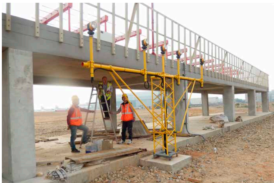
De ILS-localizer van Taiwan International Airport in aanbouw. Deerns ontwierp dit navigatiesysteem waarmee landende vliegtuigen met sterk stralende lichten veilig naar de landingsbaan worden gedirigeerd.
